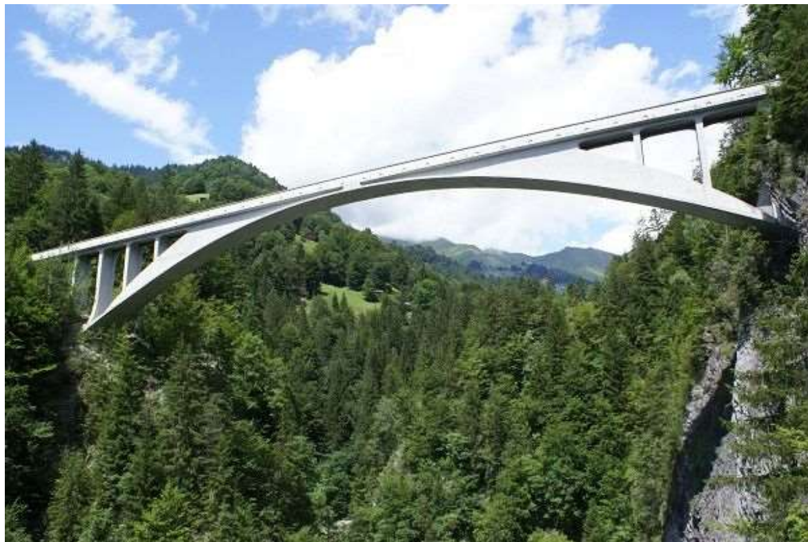
Most Salginatobel, l=120\text{m} (R.Maillart, 1930) ručně psaný statický výpočet – 44 stran !
