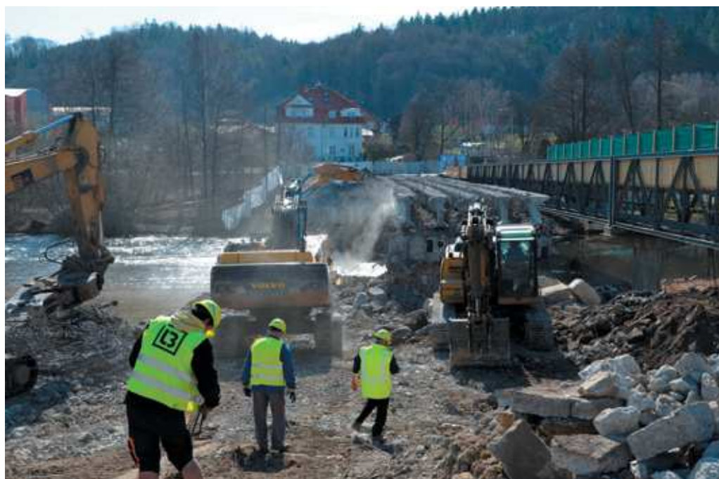
▲ Obr. 3 Demolice starého mostu
