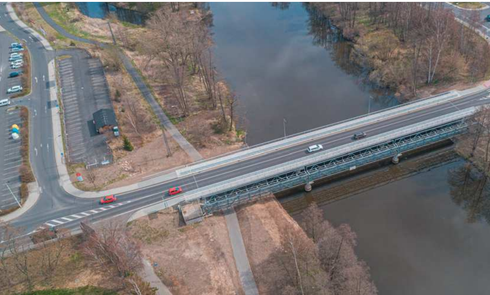
▲ Obr. 1 Pohled na stavbu nového Dvorského mostu
