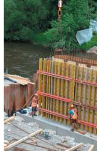
▲ Obr. 6 Výstavba pilíře mostu
