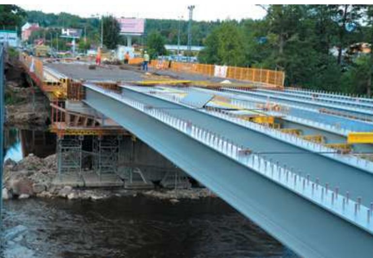
▲ Obr. 9 Spřahující železobetonová deska
