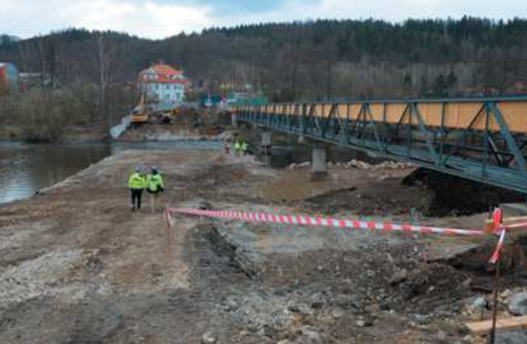
▲ Obr. 4 Stav po demolici starého mostu, vpravo lávka upravená pro pěší
