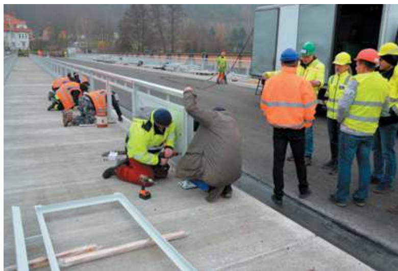
▲ Obr. 13 Vybavení mostu
