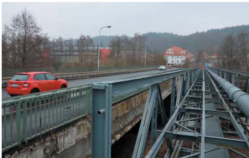
▲ Obr. 2 Pohled na starý most a technickou lávku
