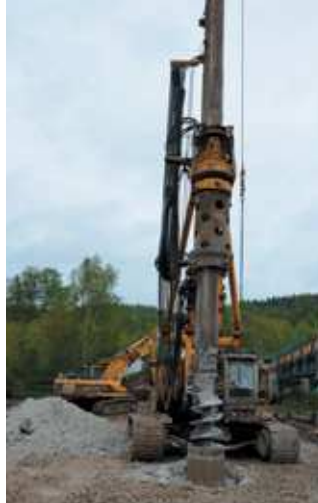
▲ Obr. 5 Vrtná souprava
