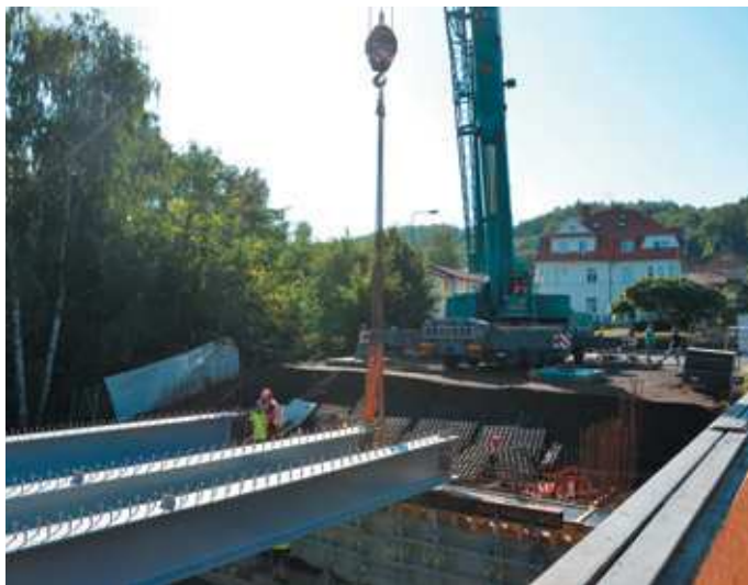
▲ Obr. 8 Osazování ocelového nosníku z pravého břehu
