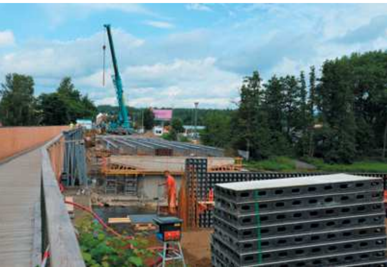
▲ Obr. 7 Osazování ocelového nosníku z levého břehu
