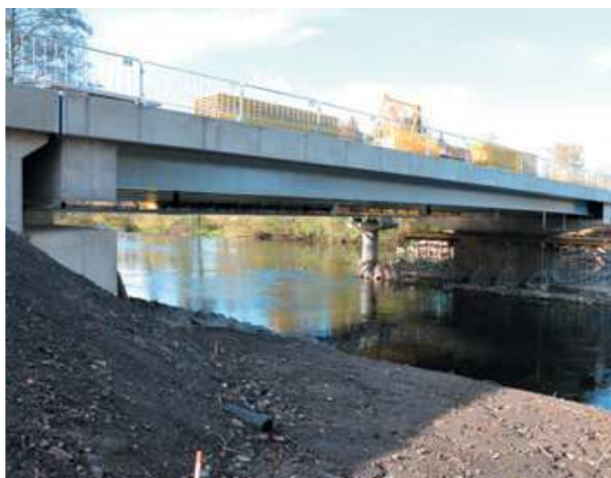
▲ Obr. 10 Pohled na výstavbu nového mostu
